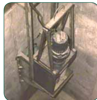
Channel Monster монтиран в помпена станция с подвижна рамка.
