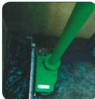
Channel Monster с удължен вал за двигателя
